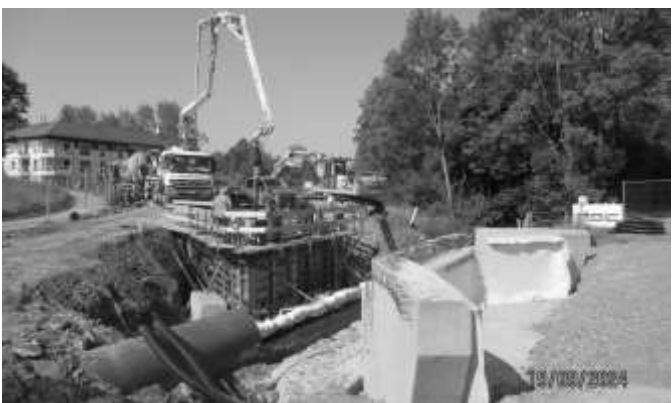
Brückenbau ©Dirk Rüdiger
